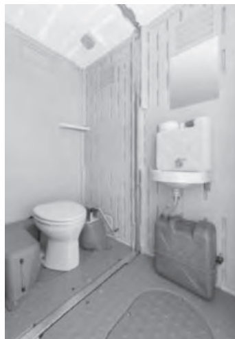
【内観 / ポンプ式簡易水洗】
